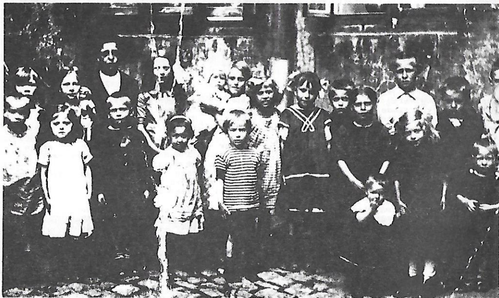
Børneparkeringen ved bymesterskabet
