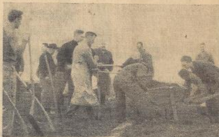
Et Kvarter efter var Arbejdet i fuld Gang, og saavel Divisionsspillet som Bestyrelsesmedlemmer tog aktiv Del i Grundgravningsarbejdet.
